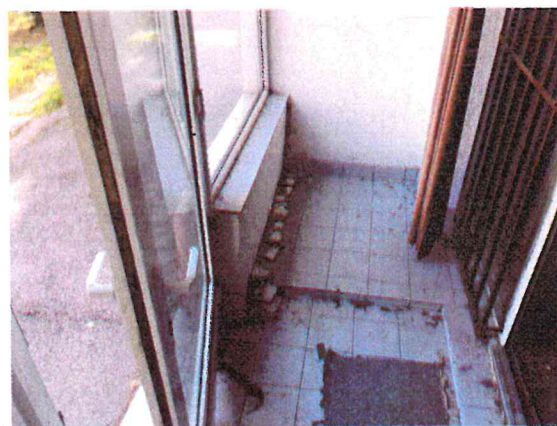
Zádverie nebytového priestoru.
