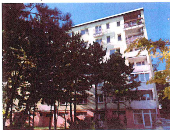
Bytová dom Cabanova 13, k. ú. BA – Dúbravka.
